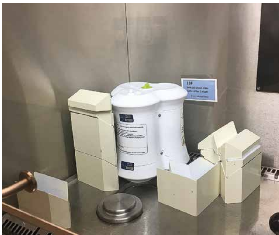
FIGUR 3. ^{68}\text{Ge}/^{68}\text{Ga} -generatoren er plassert i LAF-benk med blyskjerming.
